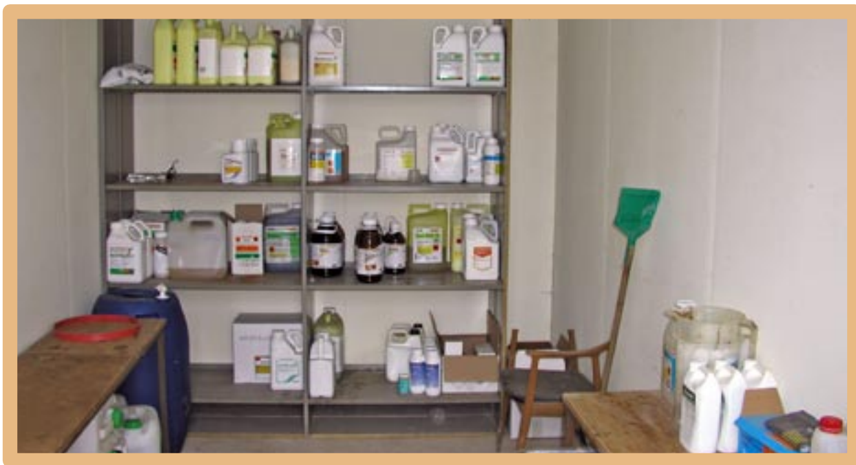
Exempel på ett preparatförråd. Plåthyllor med god ordning för bra överblick och för att undvika förväxlingar. Brandsäkra väggar och tätt golv.
